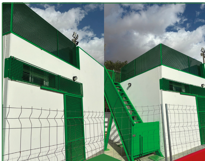
Finalización obras de vestuarios campo de fútbol.
